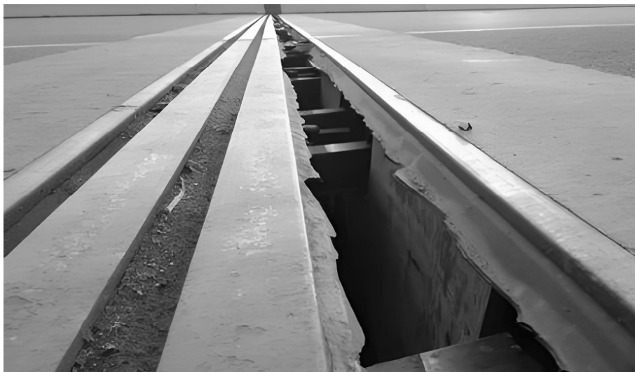
图 1 伸缩缝裂缝
