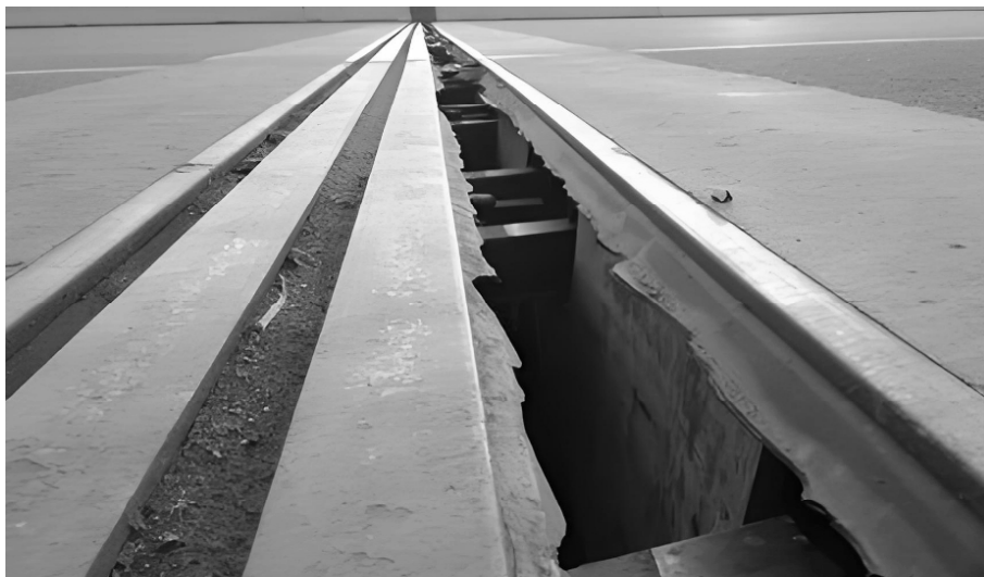
图 1 伸缩缝裂缝
