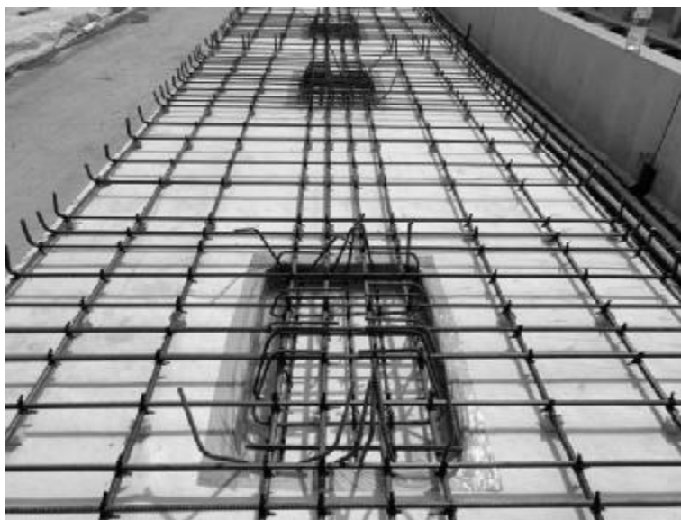
图 1 无砟轨道钢筋绑扎作业
