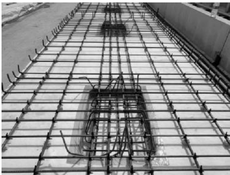
图 1 无砟轨道钢筋绑扎作业
