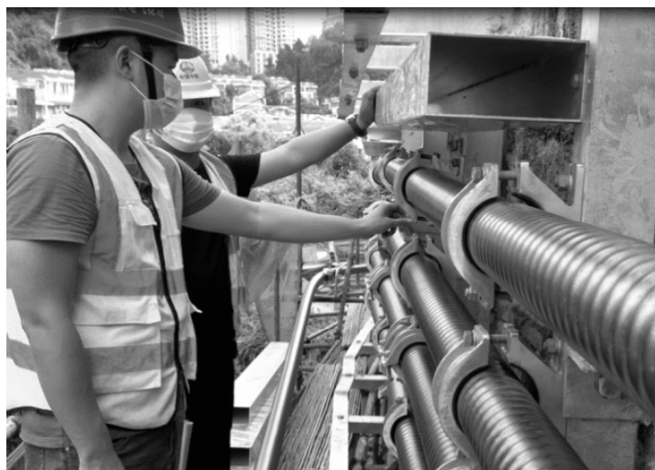
图 1 技术人员在现场展开调查工作
