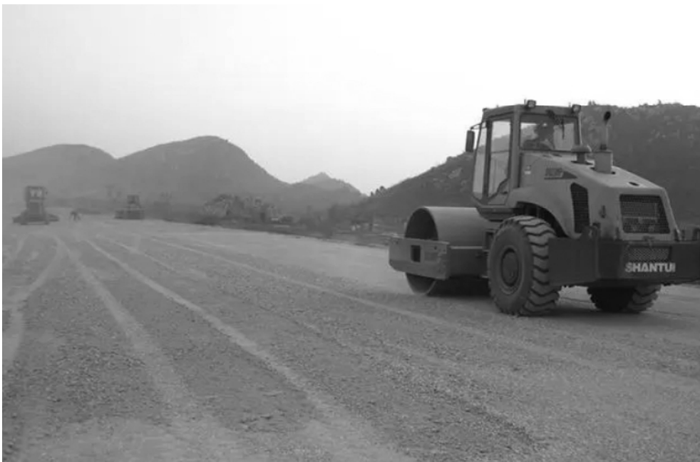
图1 机械压平路基
